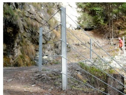
Absturzsicherung für Biker durch minimal 1.30 m hohen Zaun (Stahlprofilpfosten mit Drahtseilumfassung).
